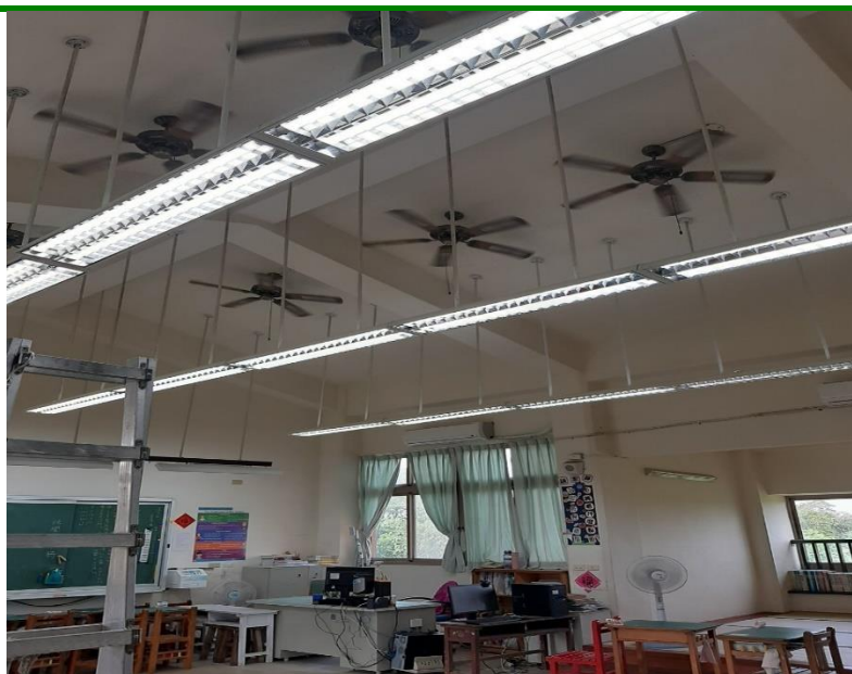
班級教室施工後
