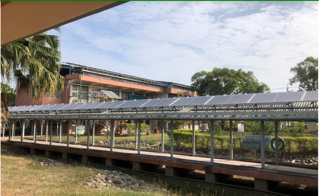
校內場地租賃給光電廠商，設置屋頂型與地面型太陽能發電設施
