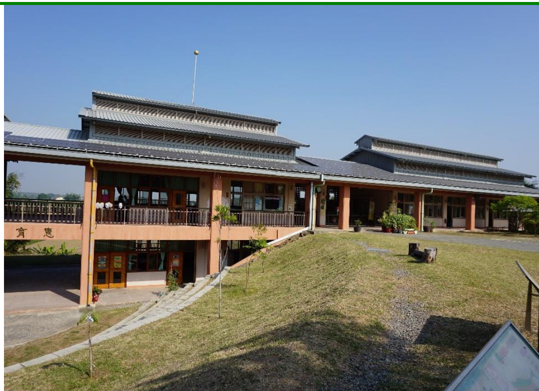
本校惠育樓屋頂南面設置太陽能板(自有及場地租賃)
