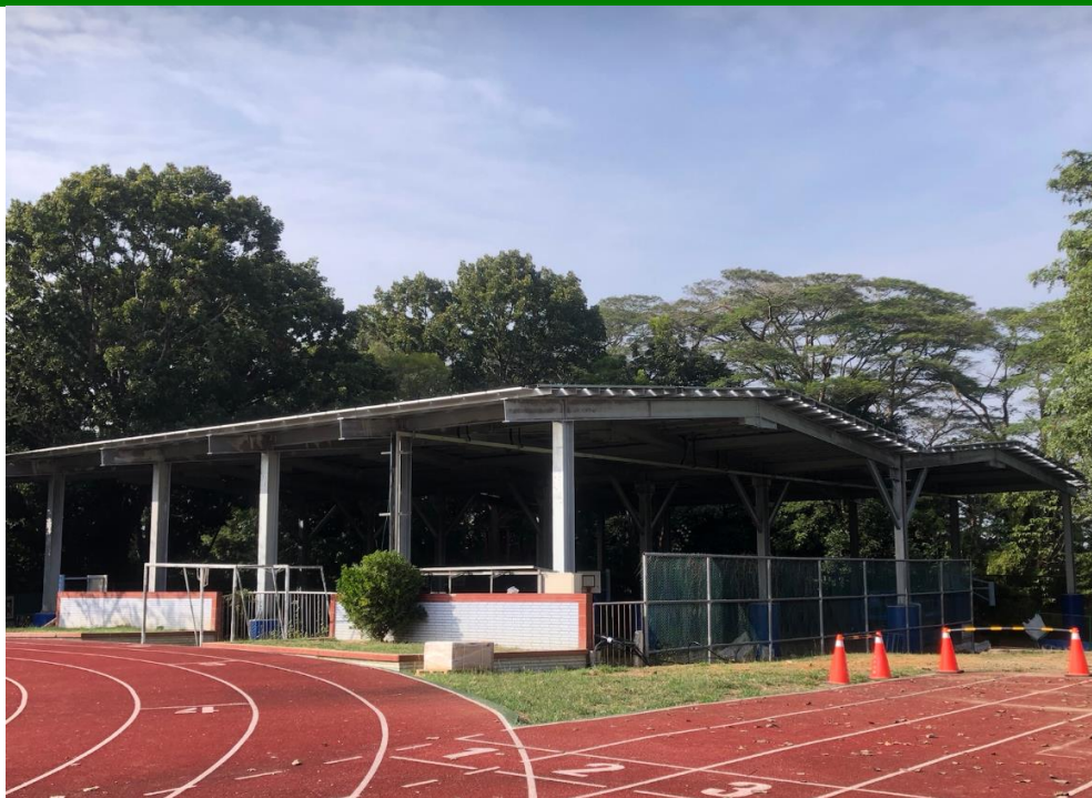
校內場地租賃給光電廠商，設置屋頂型與地面型太陽能發電設施
