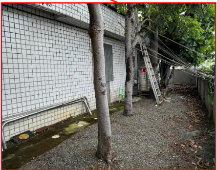
警衛室南側偏僻區域，平時請勿接近
