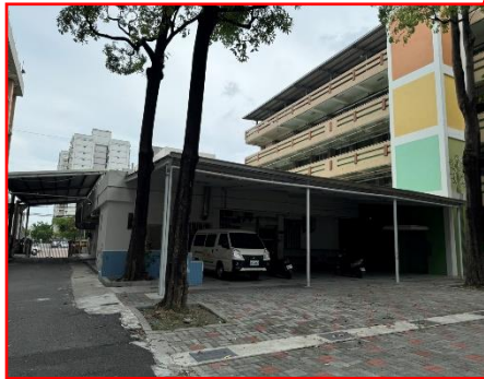
廚房作業及餐車出入區域，請勿接近
