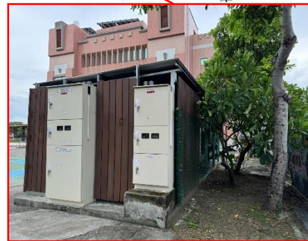
太陽能變電站有安全風險，請勿接近
