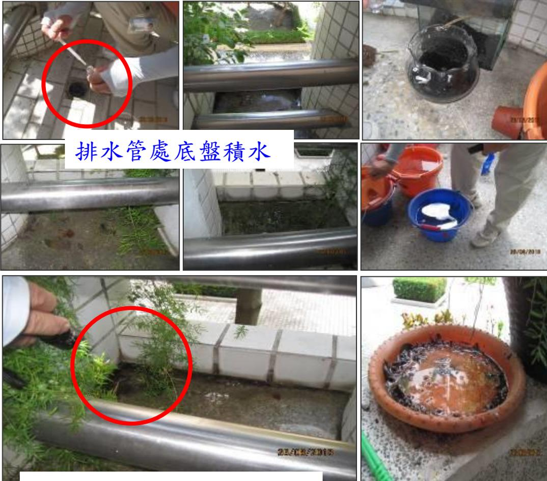
排水管處底盤積水
